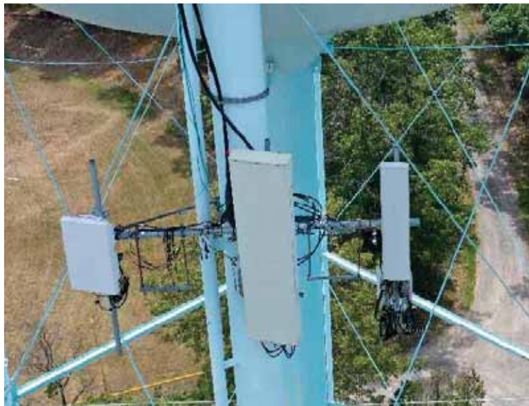
A EXIST. ALPHA SECTOR ANTENNAS SCALE: NONE
